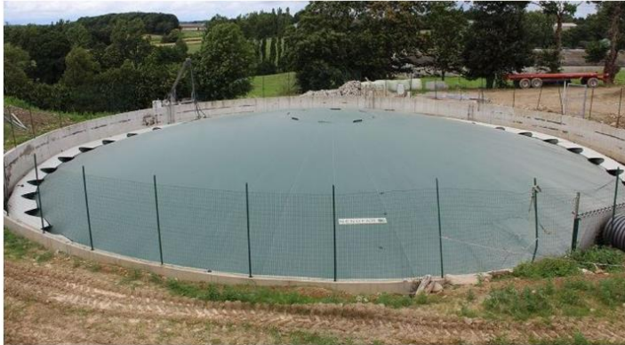
La cuve de 4 500 m 3 est alimentée via un canal par le lisier des 150 vaches laitières dont la stabulation est raclée 7 fois par jour car le lisier frais est plus méthanogène. (©Terre-net Média) https://nenufar.fr/
