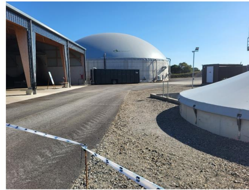
Le méthaniseur de la société CS Biogaz de Congrier - © FE 53
