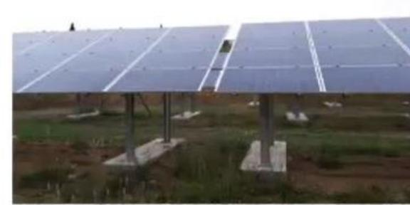
Les panneaux ne sont pas posés à même le sol, ils reposent sur des longrines, permettant ainsi l'élevage de moutons.
